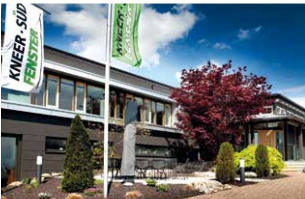
SÜD-FENSTERWERK in Schnelldorf
