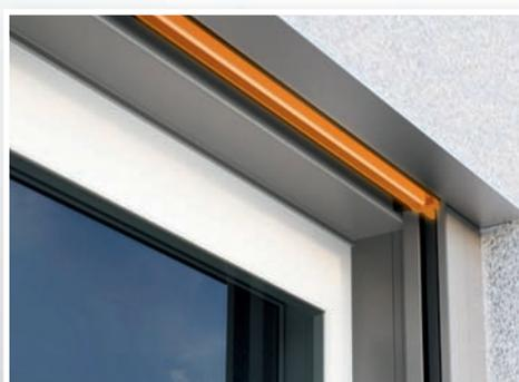
Einziehbarer Endstab für eine schöne Optik (nur möglich bei nicht eingerückter Rollladenführungsschiene)
